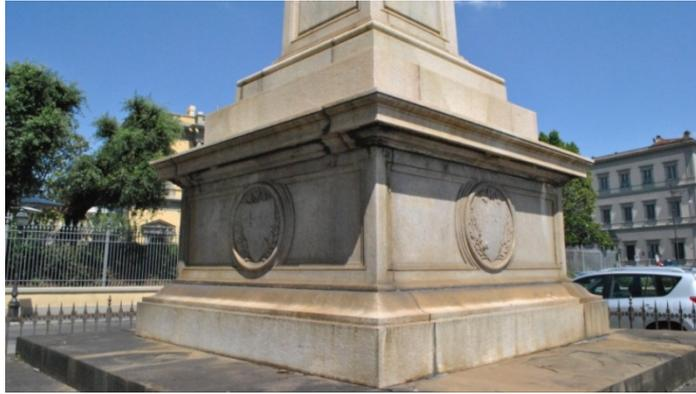
**Erosione:** Nel lato destro dello zoccolo, in particolare sotto l'iscrizione con il nome di Garibaldi, il granito è stata notevolmente danneggiato dall'erosione causata dalla pioggia e dal vento che insiste sul basamento, causando la difficile lettura dell'iscrizione. Allo stesso modo gli scudi del dado del basamento sono degradati, soprattutto il retro della scultura, dove non è più leggibile l'iscrizione.
